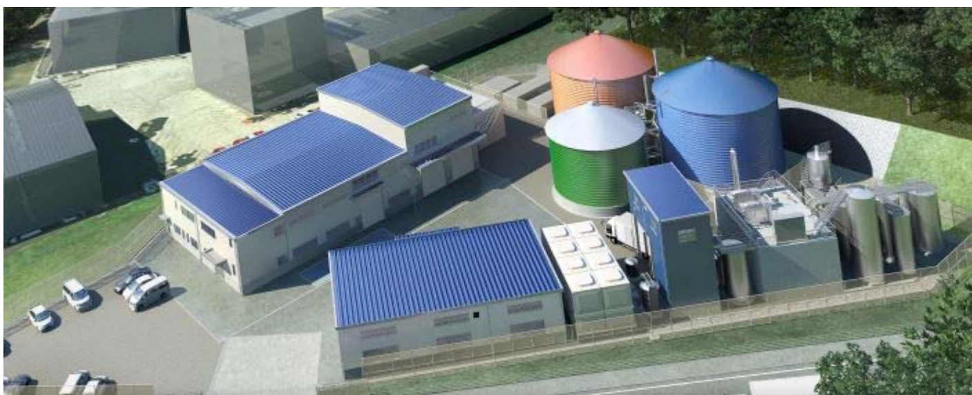
牧之原バイオガス発電所
