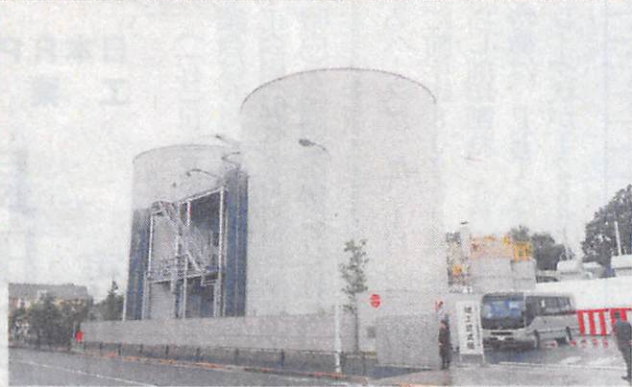
都内で食りの貴重な受け皿として 竣工した羽村バイオガス発電所
