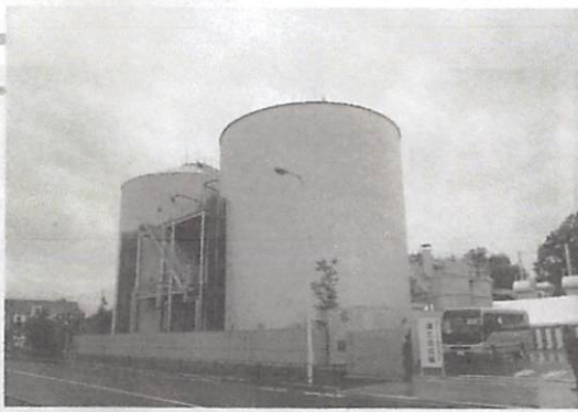
東京都内で食品リサイクルの貴重な受け皿となる羽村バイオガス発電所
